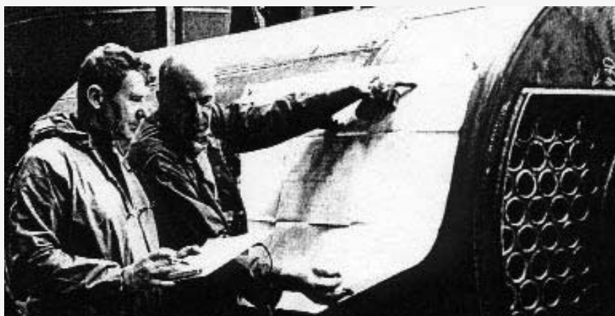
Проверка соответствия котла Viatomax технической документации
