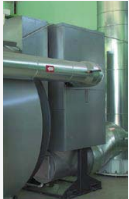
Водогрейный котел серии Vitomax 200, оснащенный экономайзером Vitotrans 333
