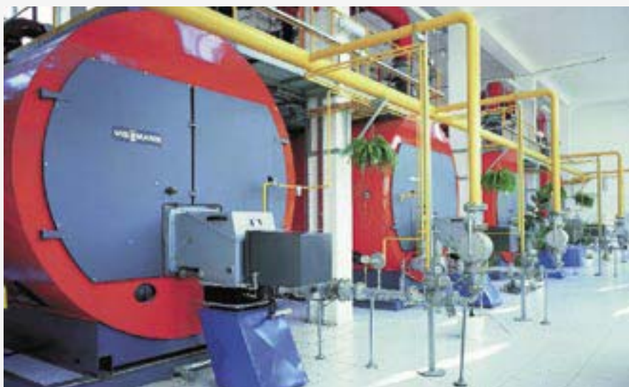
Turbomat-RN-HW – водогрейная котельная 6 x 10 МВт
