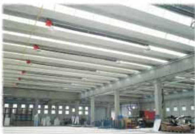
Рис. 10 Система отопления PANRAD: цех производства холодильных установок
