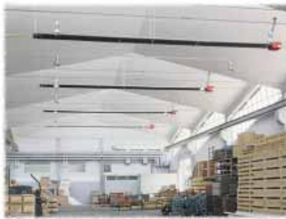
Рис. 11 Система отопления PANRAD: цех металлоконструкций
